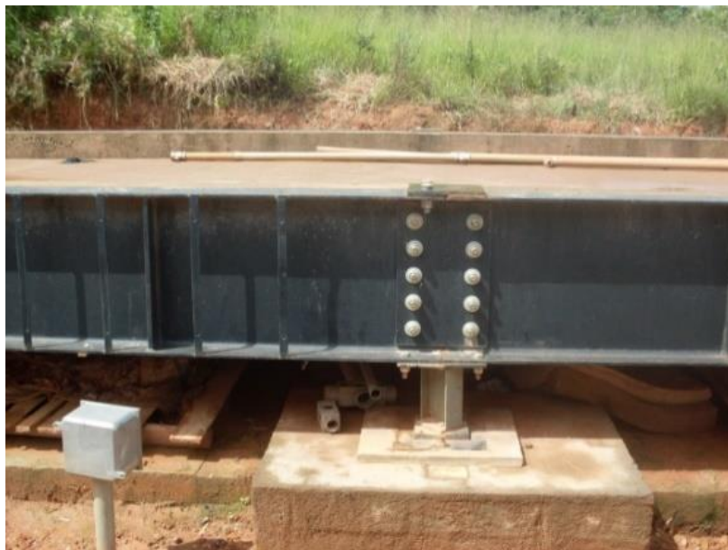
Figura 130 - Portão de entrada do aterro e plataforma para balança.
