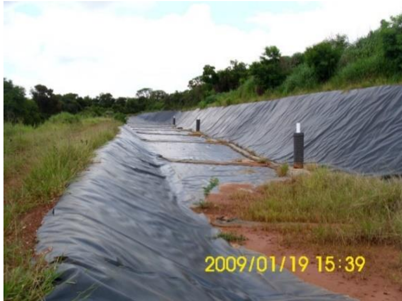
Figura 131 - Manta para impermeabilização e drenagem do percolado.
