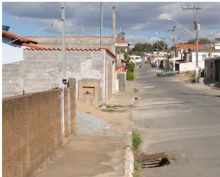
Figura 16 - Obstrução de passeio por areia e brita.
