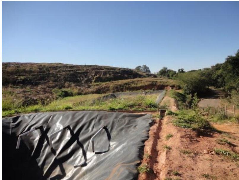
Figura 138 - Sistema de tratamento de lixiviados por Lagoa de Estabilização.
