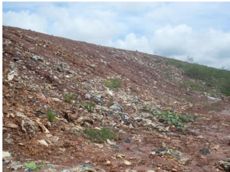
Figura 119 - Escoamento superficial do chorume
