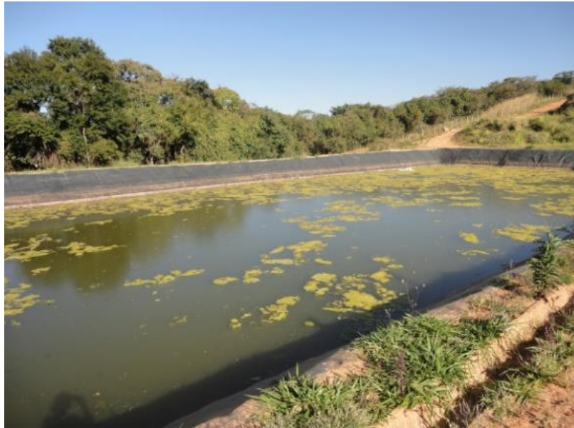
Figura 140 - Sistema de tratamento de lixiviados por Lagoa de Estabilização.
