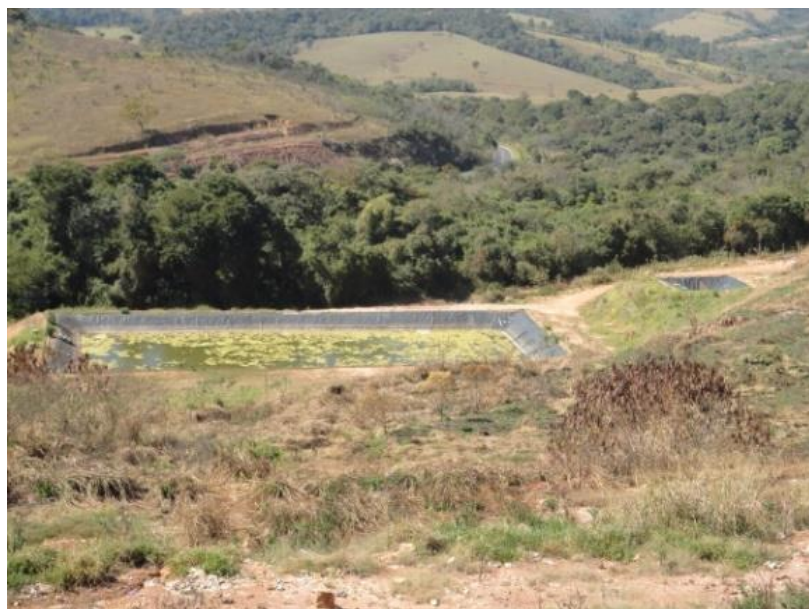
Figura 139 - Sistema de tratamento de lixiviados por Lagoa de Estabilização.
