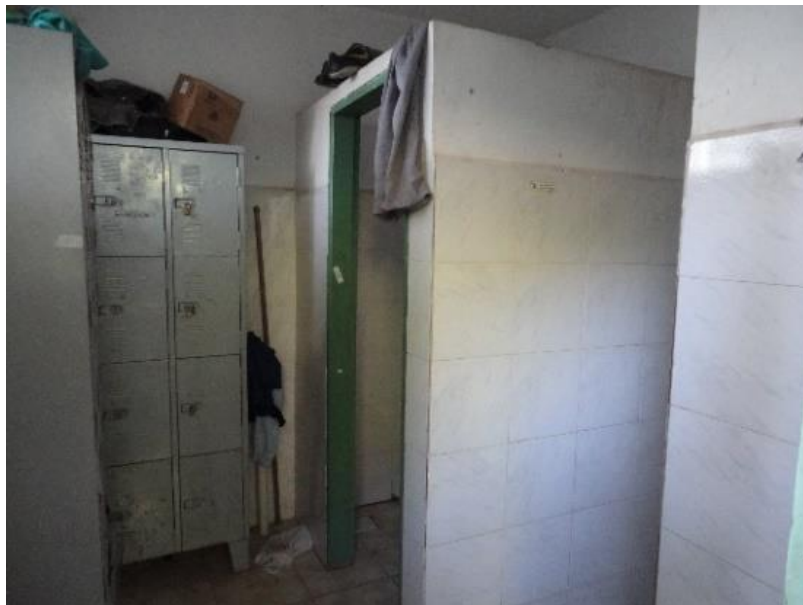
Figura 61–Escritório e banheiro do centro de triagem.
