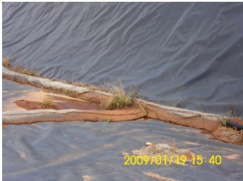
Figura 132 - Manta para impermeabilização e drenagem do percolado.
