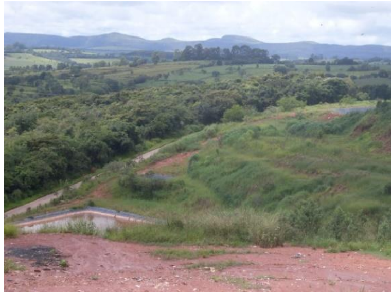
Figura 116 - Visão geral do antigo lixão e estrada de circulação.
