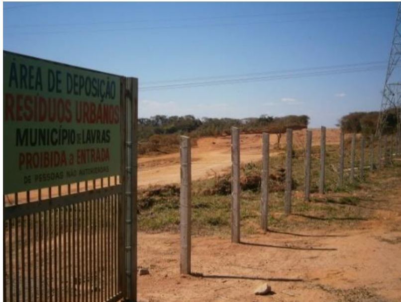
Figura 129 - Portão de entrada do aterro e plataforma para balança.
