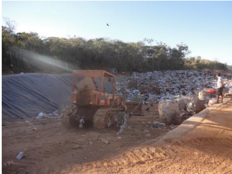
Figura 135 - Resíduo a ser aterrado, espalhamento e compactação
