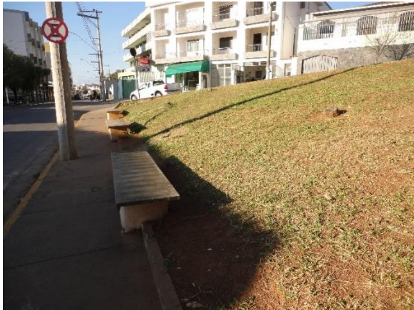
Figura 15 - Trechos de calçadas da Av. Silvio Menicucci e Rua Delfino de Souza
