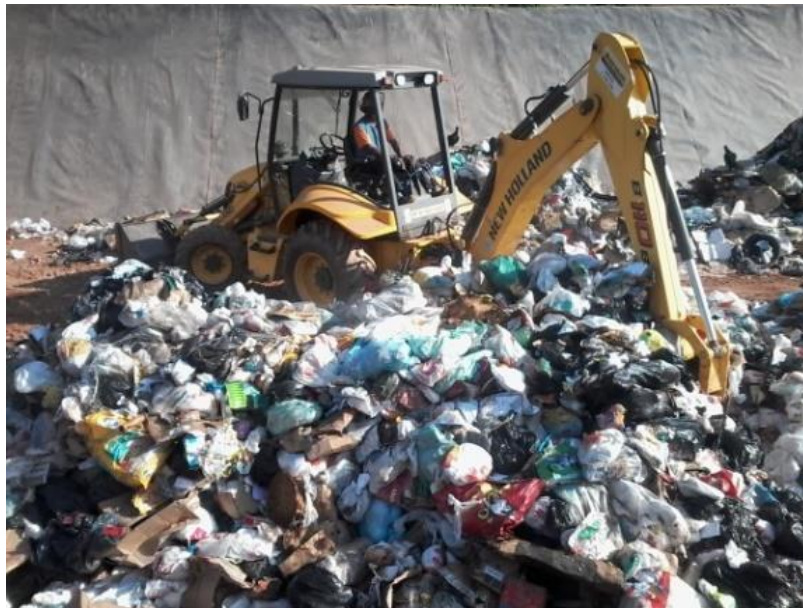
Figura 96 - Procedimento de quarteamento realizado.
